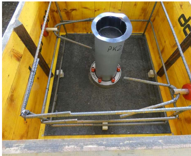
Bild 1 Prüfkörper in der Schalung vor der Betonage
